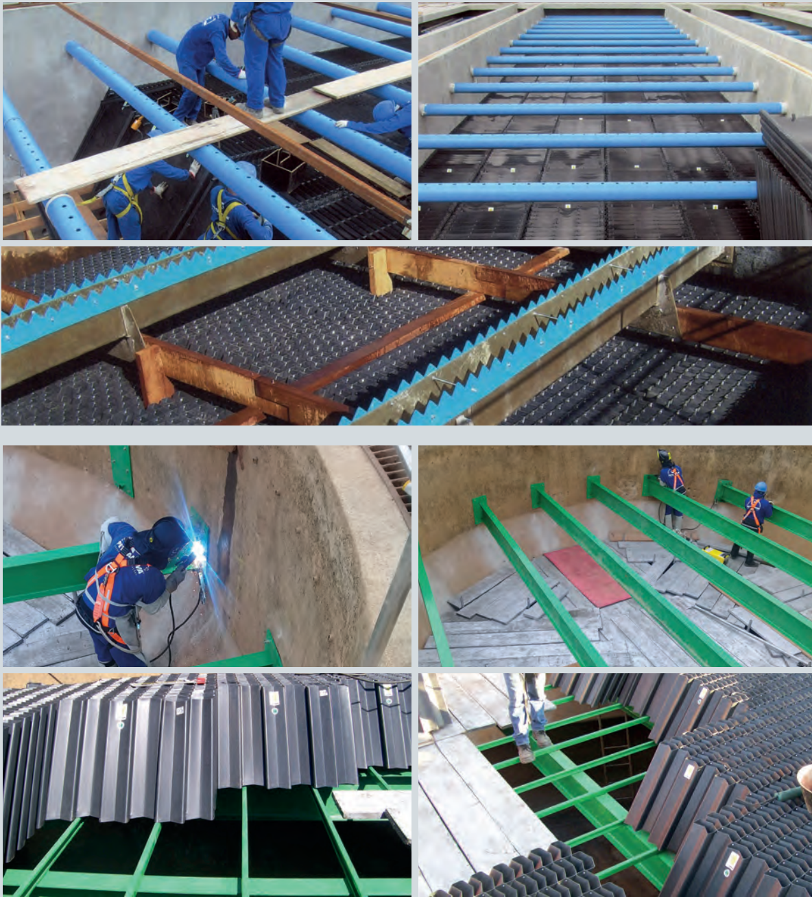
Instalação de decantador circular com estrutura em aço e módulos tipo chevron na Ambev em Anápolis/GO
