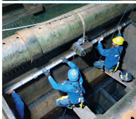
Em cima, instalação do sistema PETRADECK® na E.T.A. de Itapetininga-Sabesp
