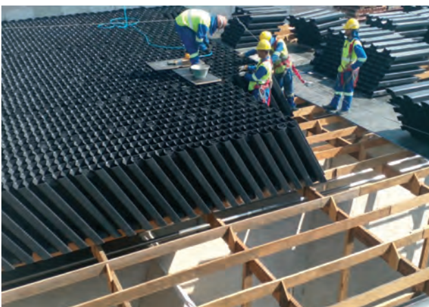
Instalação de módulo Duplo G na E.T.E. Pirajussara da SABESP
