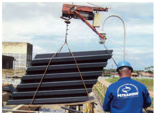
Instalação de perfis Petranova® na E.T.A. Pratagy, da Casal em Maceió/AL
