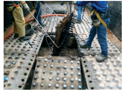
Placas pré-moldadas rompidas sendo substituídas pelo sistema Petralock® na Suzano Papel
